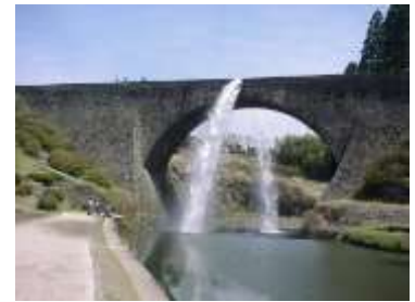
通潤橋 山都町のHPから
